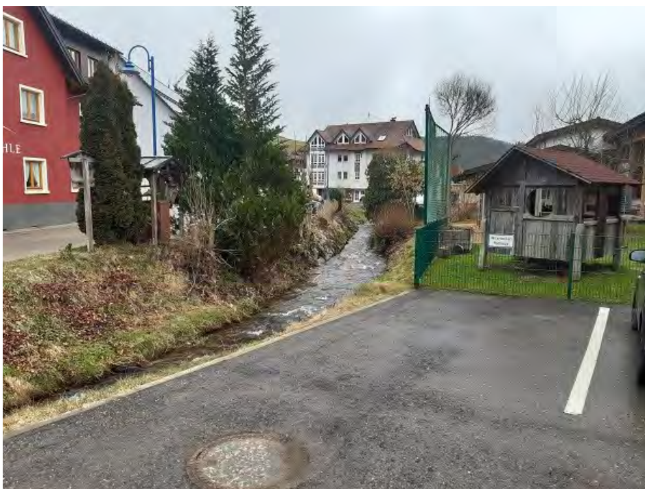
Abbildung 5 Nordufer des Hintertälerbaches mit Blocksteinen, Standpunkt westlich des Außenbereiches des Kindergartens, Blickrichtung Osten, Februar 2022
