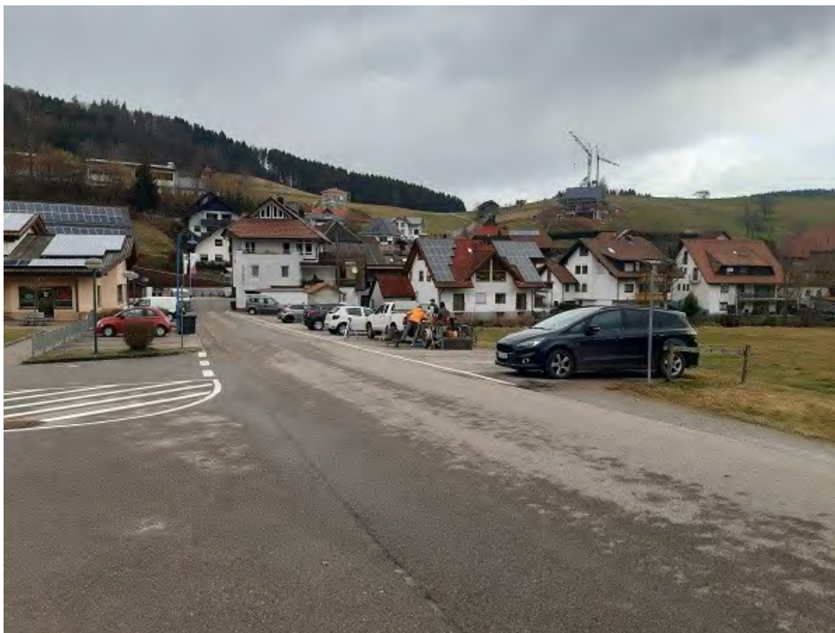
Abbildung 1 Südlicher Bereich der Projektfläche, Blickrichtung Norden, Februar 2022, links im Bild Kindergarten St. Martin
