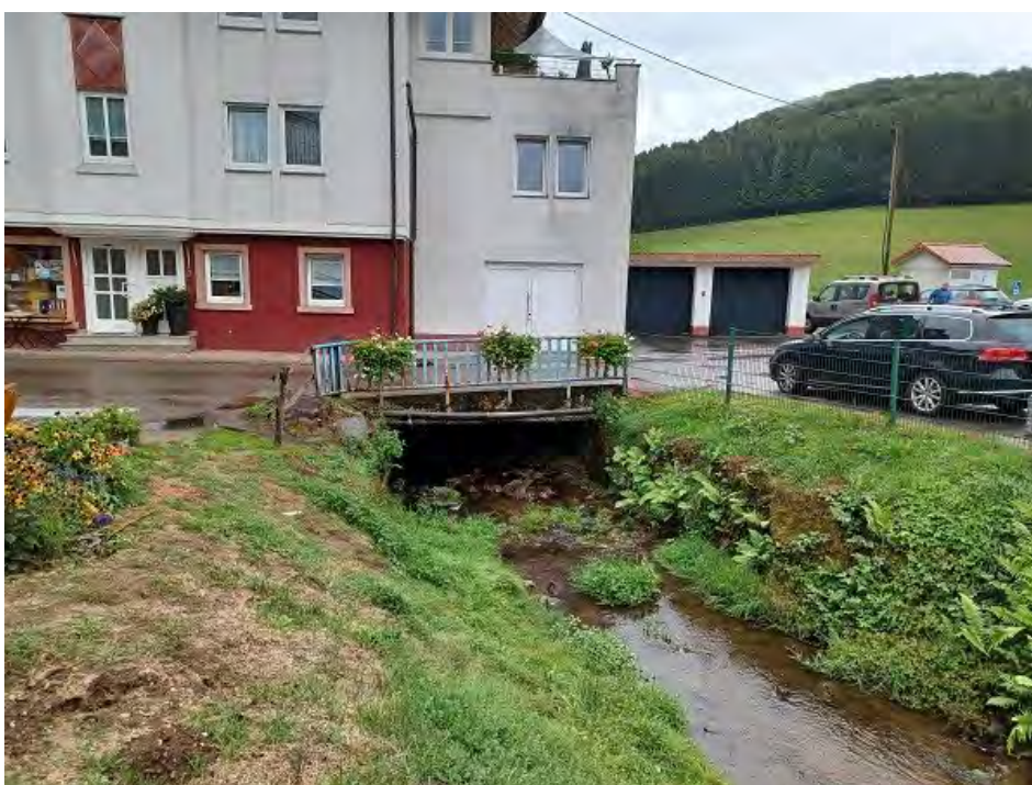
Abbildung 3 Bestandsbrücke über den Hintertälerbach, Blickrichtung Osten, September 2022
